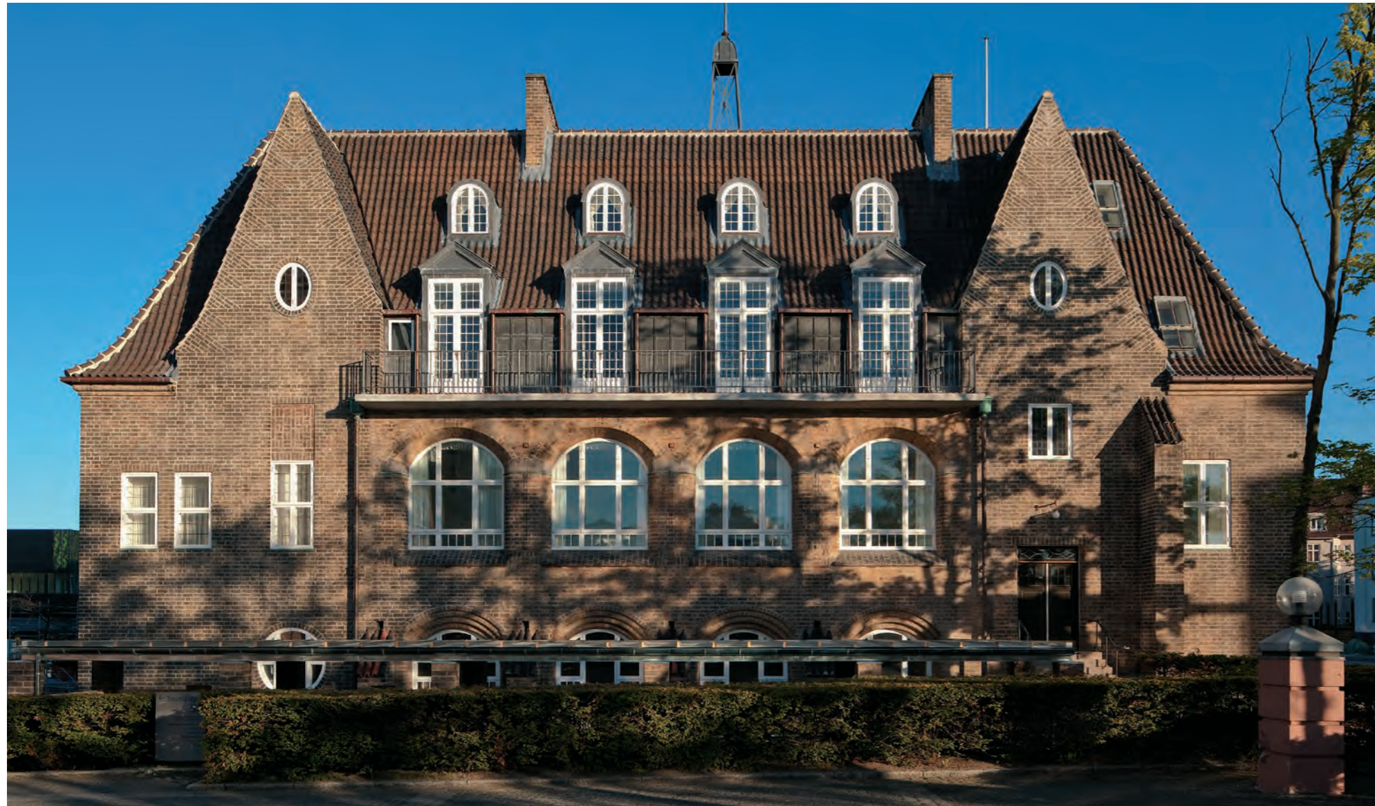
Rosenhuset - Tuborgs gamle administrationsbygning fra 1913 - er tegnet af arkitekten Anton Rosen som et gesamt-kunstværk i skønvirkestil.
