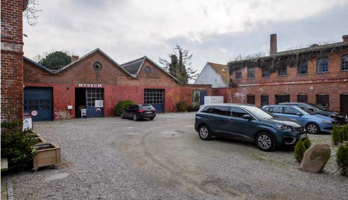
Støberihallerne i Præstø. Shedtaget giver mest muligt lys ned i de lange haller, og zigzag-formen er typisk for tidens industribygninger.
