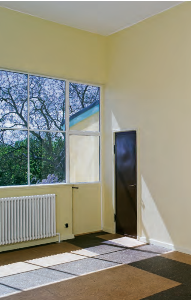
Væggene i den centrale stue i Edvard Heibergs eget hus blev malet med lys okker limfarve. Farveholdingen er nu rekonstrueret.
