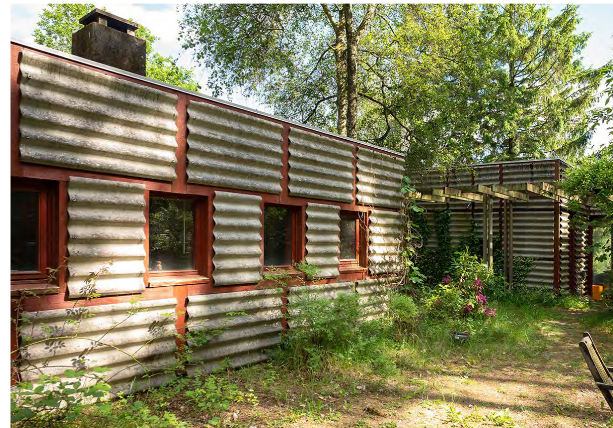
Arkitekten Poul Erik Thyrrings eget hus ligger fredfyldt gemt væk i en skov ved Skjern Å og skiller sig markant ud fra andre huse ved sit materialevalg og rå, brutalistiske stil. Huset blev købt af Realdania By & Byg i 2021 og er ikke fredet.
